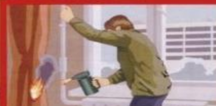
Отогревание замерзших труб паяльными лампами и факелами
